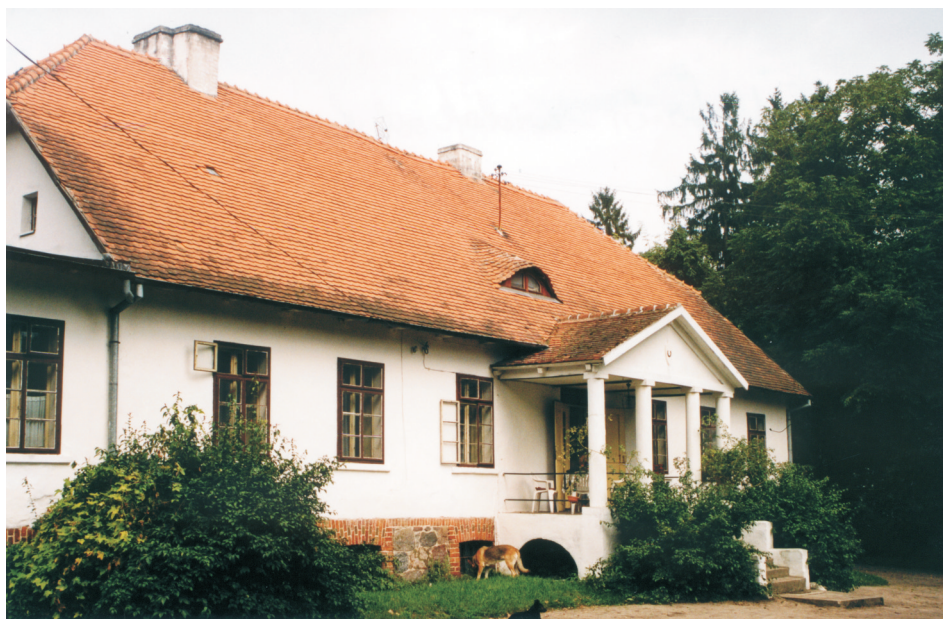
Fot. 1. Dwór – widok od strony południowej Phot. 1. The maner-house – a view from the south (fot. – photo by M. Czekański)
