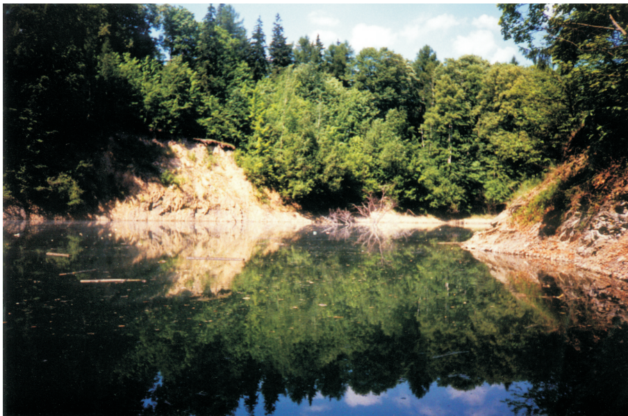
Fot. 3. „Jeziorko Daisy” – widok na obsuwającą się skarpe (fot. B. Bałuka) Phot. 3. The reserve “Jeziorko Daisy” – a view of a sliding bank (photo by B. Bałuka)
