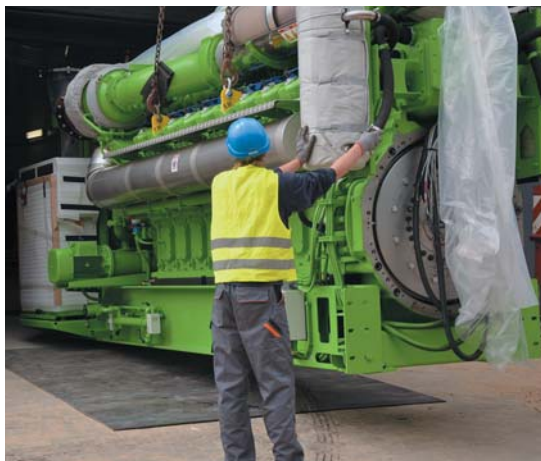
Montaż agregatu
